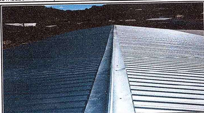
Foto 1: Estructura de techo del modulo 1,2 y 3
