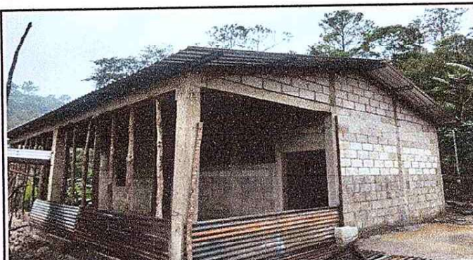
Foto 4: Construcción hecha de puerta y ventana del modulo 4,5 y 6
