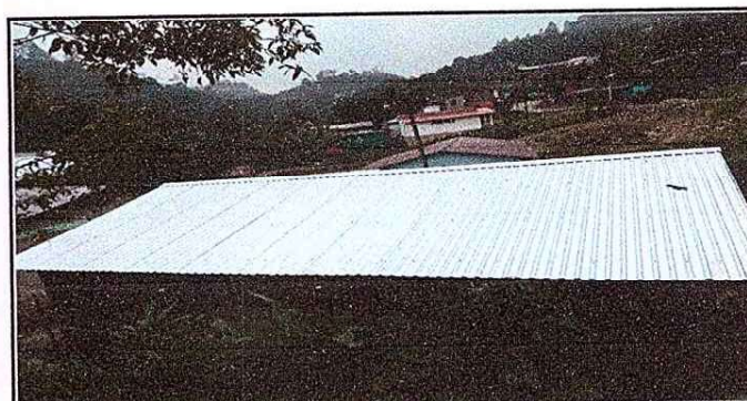
Foto 6: Estructura de techo remodelado 4,5 y 6
