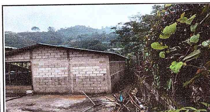
Foto 5: Pared remodelada del modulo 4,5 y 6
