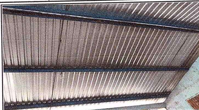
Foto 2: Estructura de techo interior del modulo 1,2 y 3
